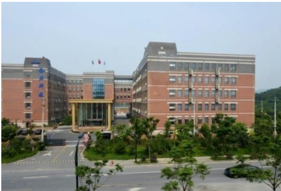
杭州市西湖区云栖小镇-公司总部
